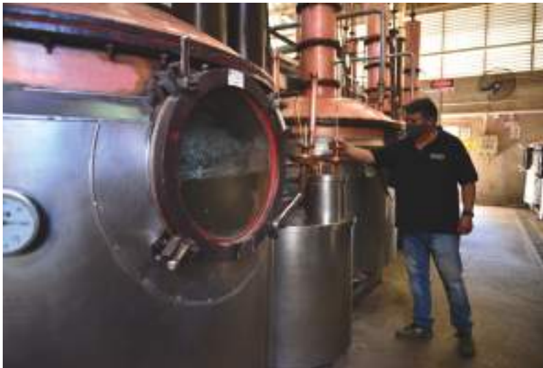
Destilería Mal Paso
