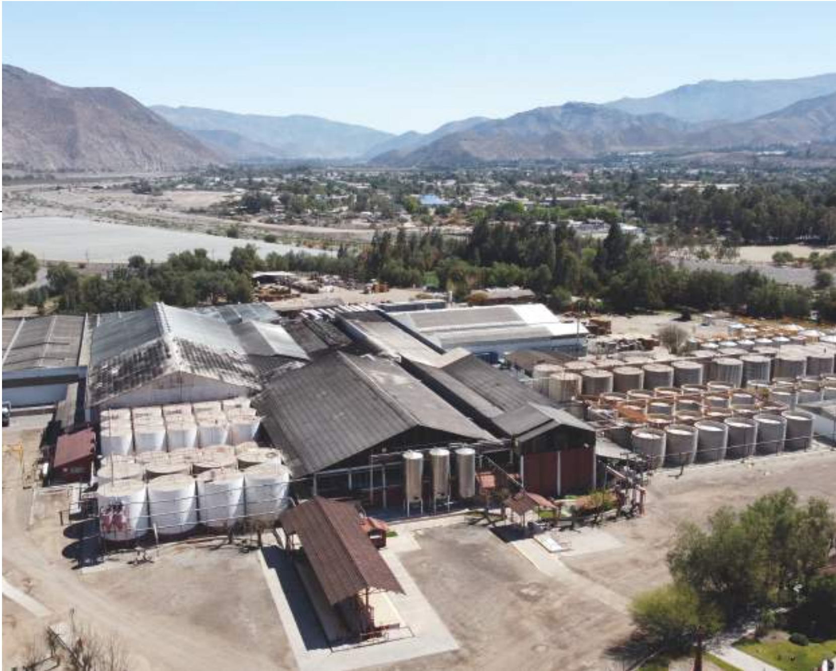
Toma aérea planta destilería Capel
